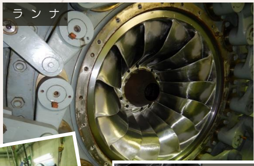
ランナの 摩耗状況 を確認
